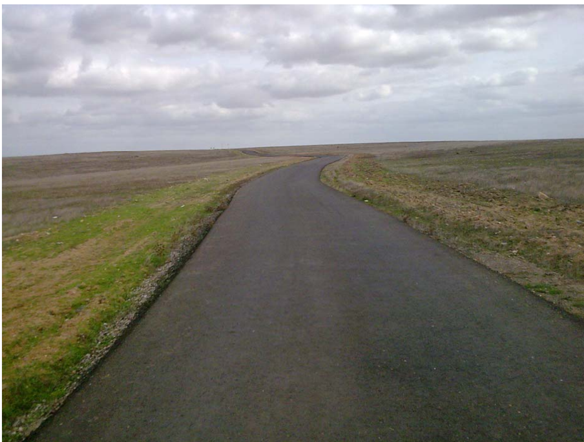
Foto 1– Caminho público alternativo, recentemente pavimentado, situado a norte da Pedreira
